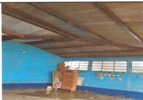
Foto 3: Parte interior de las aulas.
